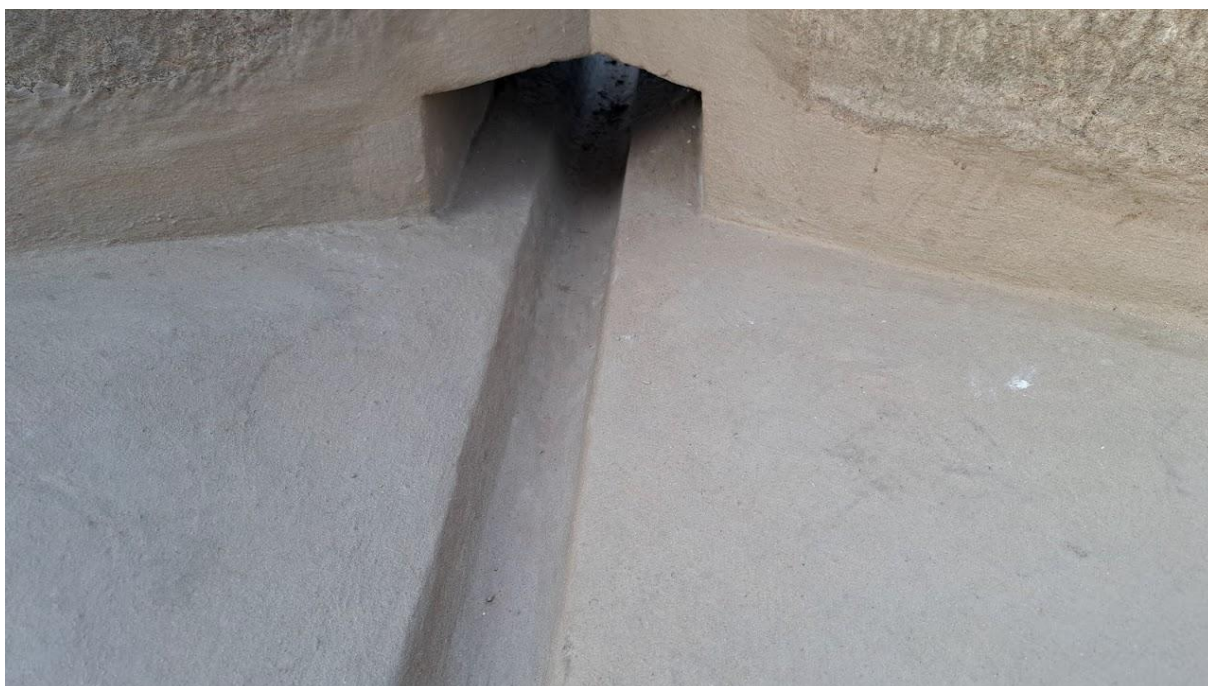
Po restaurování cimbuří a hydroizolace.
