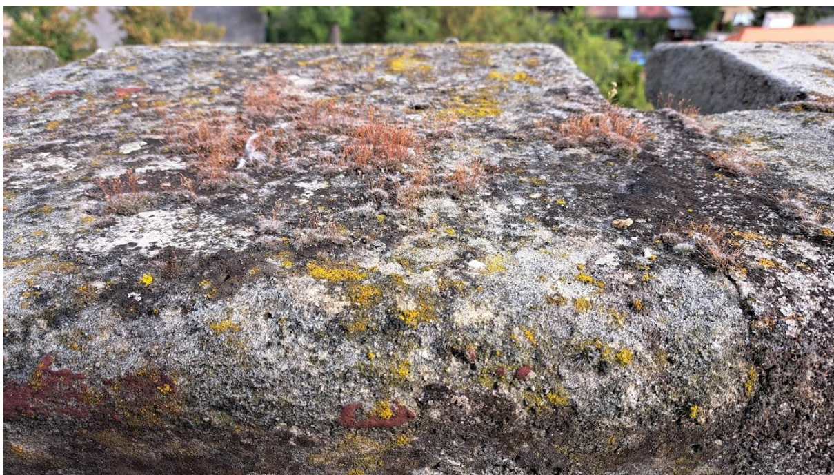
Ochoz mezi tzv. helmicí věže a cimbuřím.
