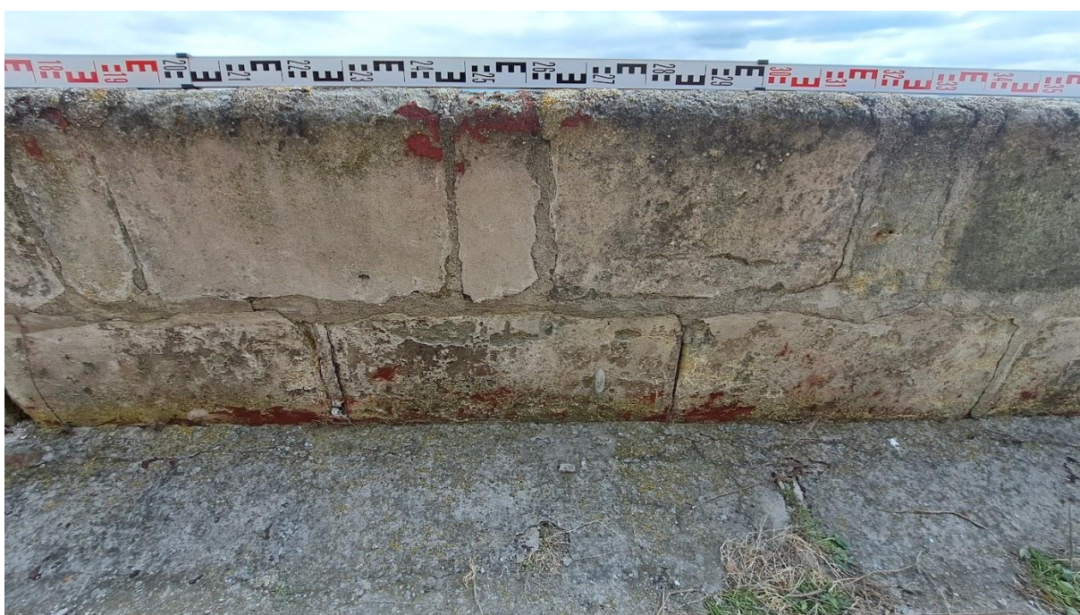
Pískovcový ochoz - cimbuří věže.
