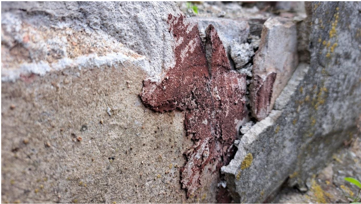
Opravné vrstvy cementu.
