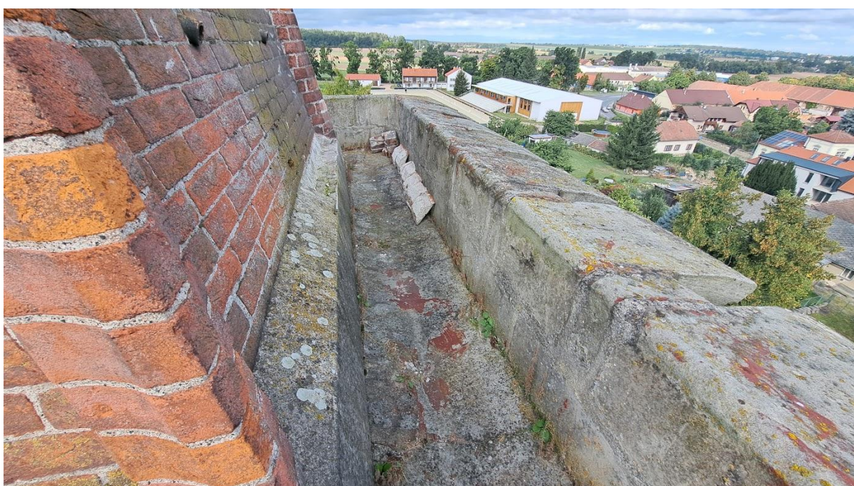
Ochoz mezi tzv. helmicí věže a cimbuřím.
