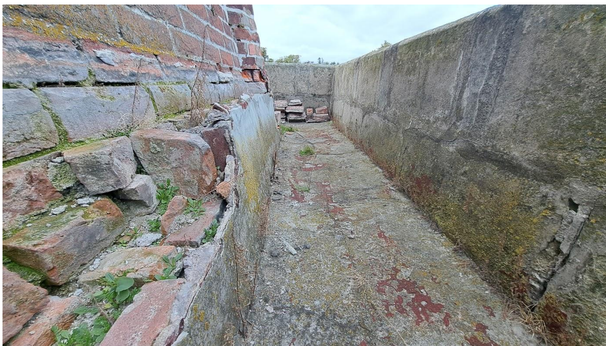
Ochoz mezi tzv. helmicí věže a cimbuřím.
