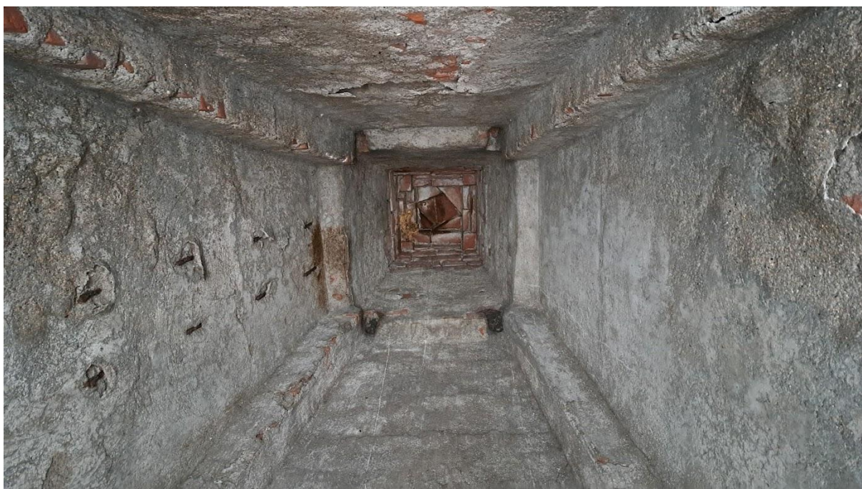
Vnitřní strana zděné helmice věže.
