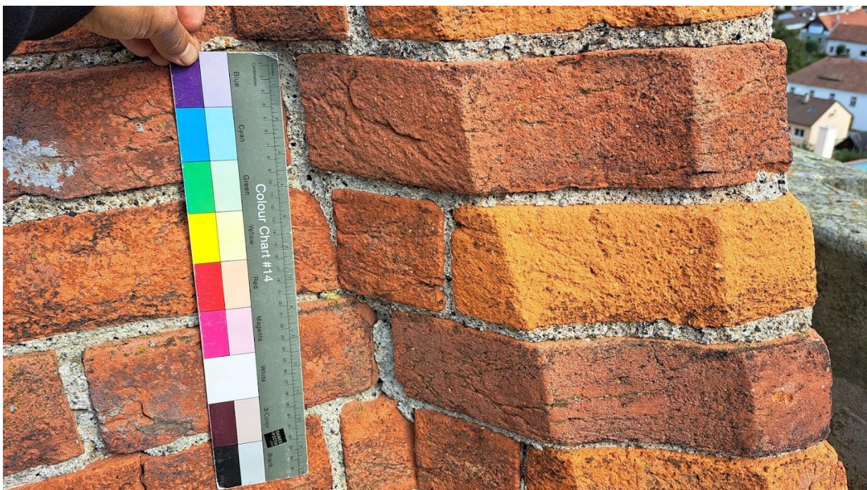
Detail cihlových profilů na hranách jehlanové věže.
