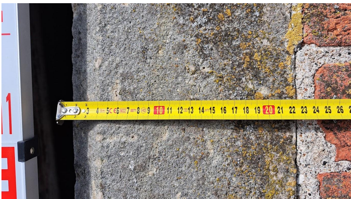
Rozměry pískovcového vstupního ostění na ochoz věže.
