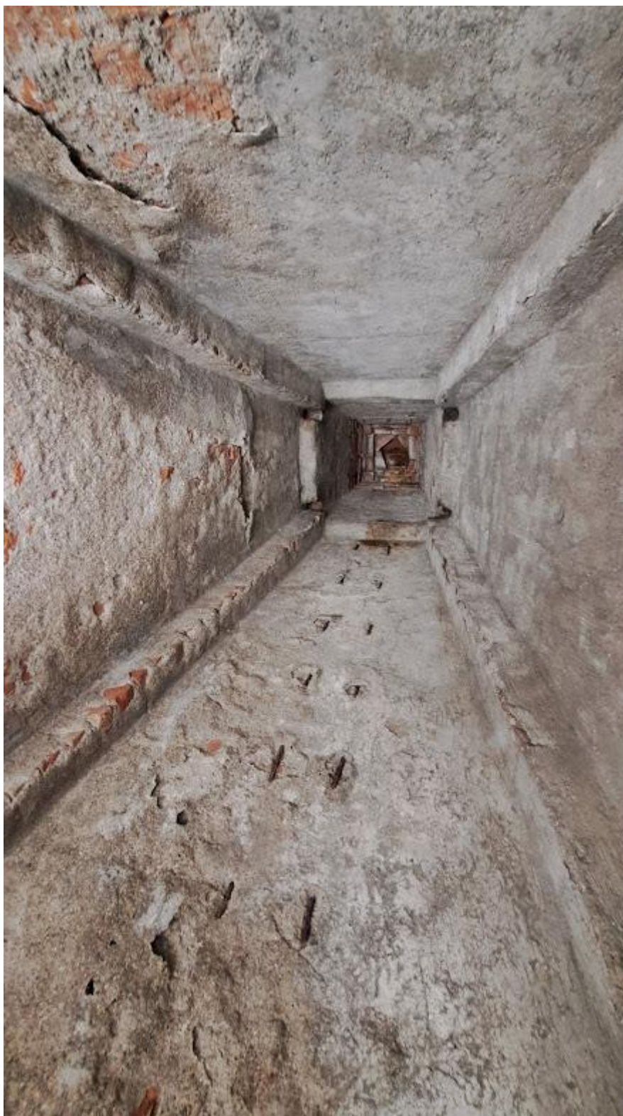
Vnitřní strana zděné helmice věže.
